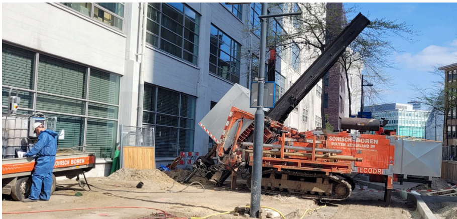
Op deze foto worden de schuine injecties aangebracht
