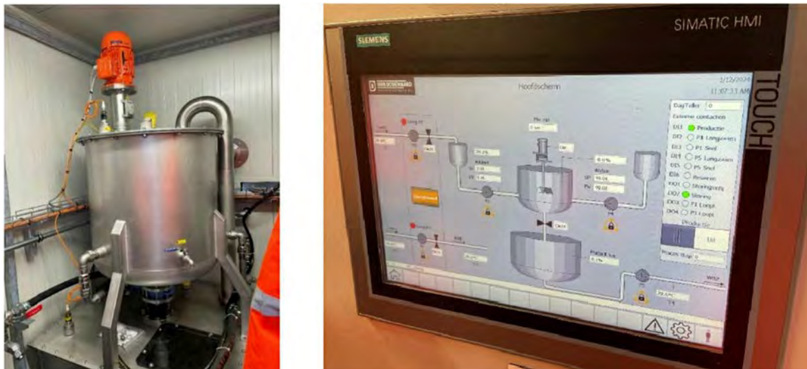
Figuur 9. Buffervat gemengd materiaal (links) en besturing hoeveelheid additief en water (rechts)
